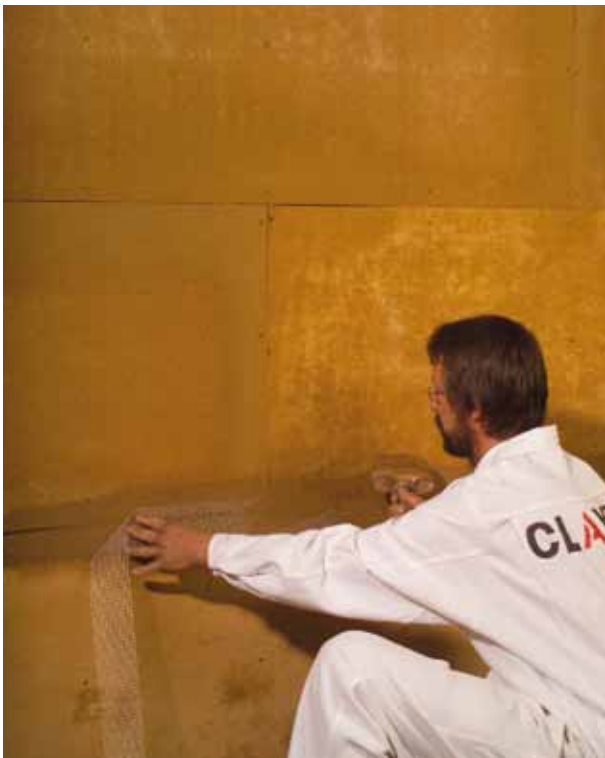
Abbildung 5.2.6: Einarbeiten der Fugenarmierung, mit sorg- fältiger Bearbeitung der Randbereiche
