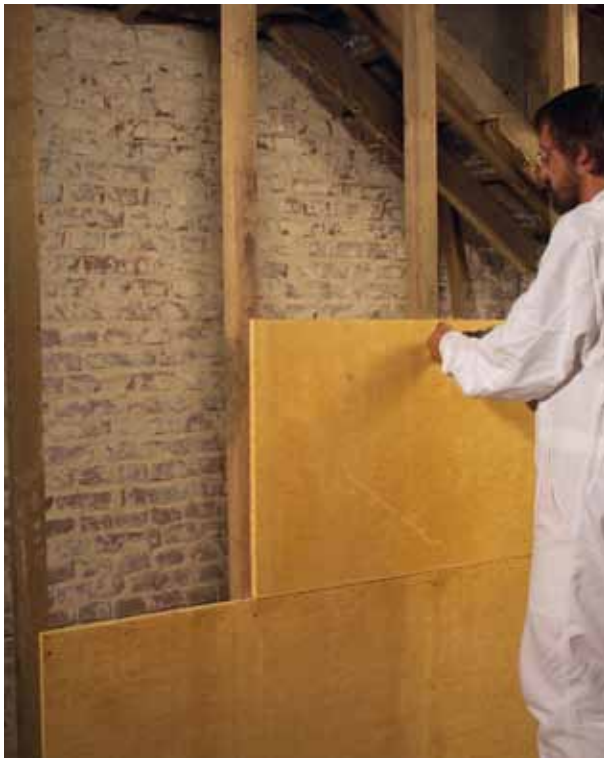
Abbildung 5.2.1: Montage der Lehm- oder Gipsbauplatten am Pfostenwerk einer Ständerwand/ Vorsatzschale
