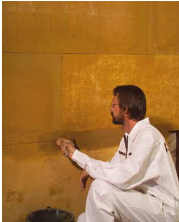
Abbildung 5.2.5: Vorziehen der Schlämme aus Claytec Lehm-Oberputz fein
